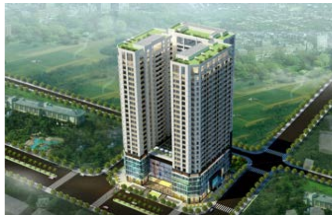
Dự án Central Fiel Số 219 Trung Kính, Cầu Giấy, Hà Nội
