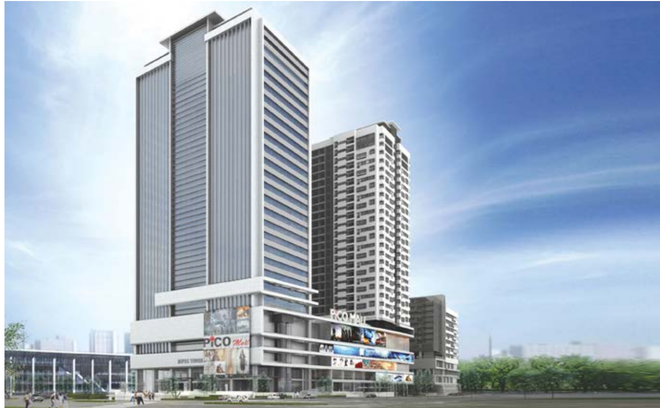
Tòa nhà Mipec Tower Số 229 Tây Sơn, Đống Đa, Hà Nội
