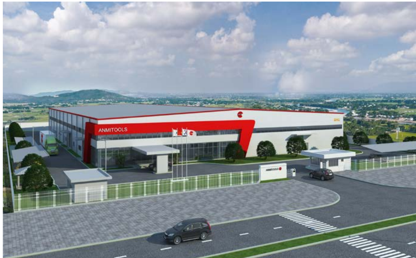
Nhà máy gia công chế tạo cơ khí Anmi Tools Phố Nối B, Dị Sử, Mỹ Hào, Hưng Yên
